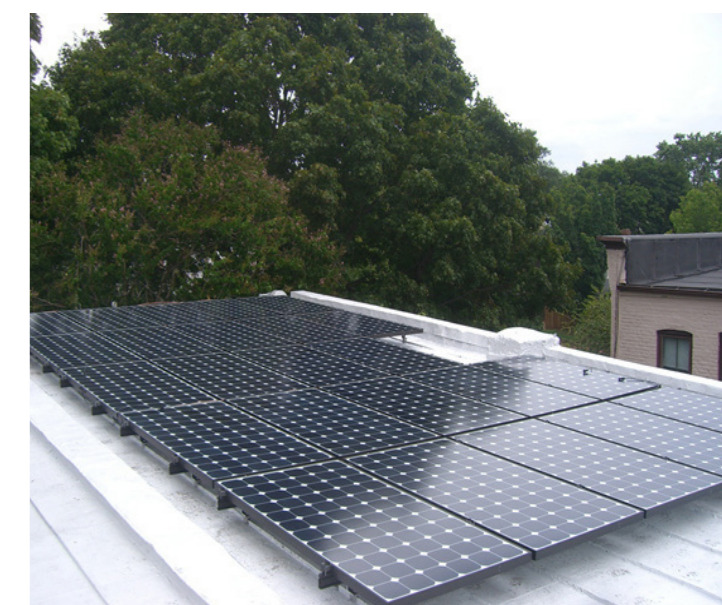
20kWp PV Array
