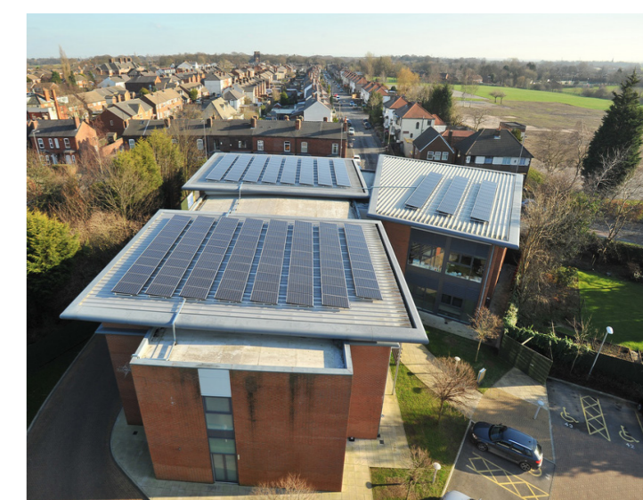
45kWp PV Array
